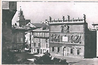
Le bâtiment au début du XX e
