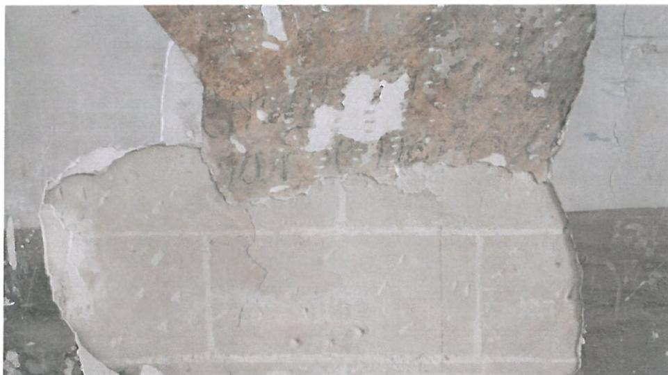
Les baies du niveau 2 ont des tableaux chanfreinés tel que cela ce faisait à cette époque. Les ouvertures du niveau 1 ont été modifiées et des traces d'arc et des bouchages d'ouvertures sont lisibles.
